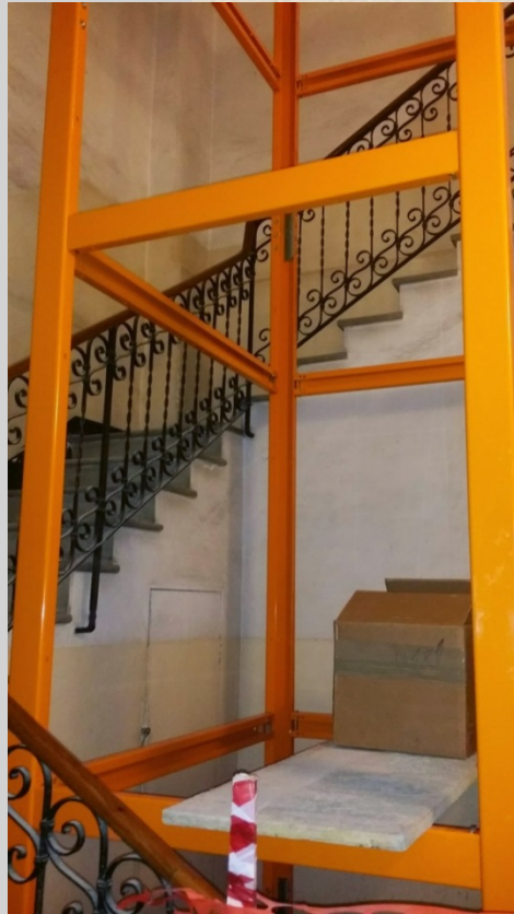
AMPIO VANO PREFABBRICATO
